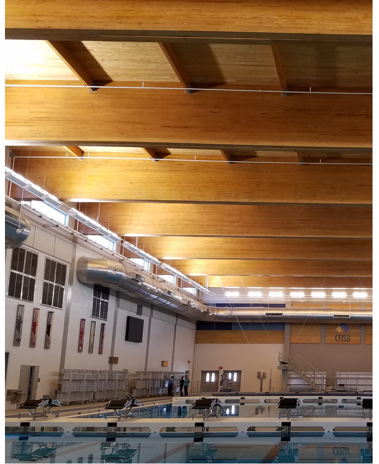
Prigdeon Natatorium - Cypress, TX
